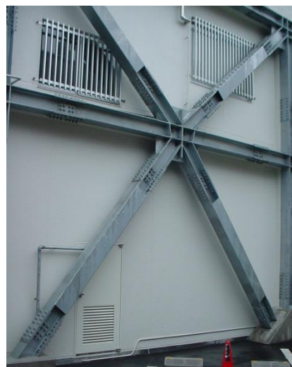
外観 耐震工事（裏面）
