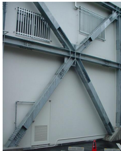
外観 耐震工事（裏面）
